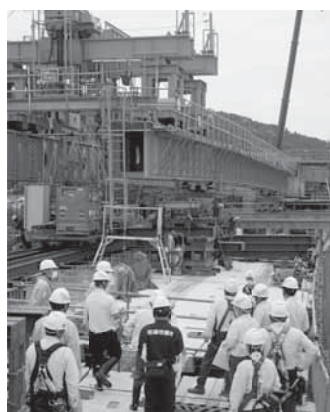
【松浦佐々道路の橋梁見学】
