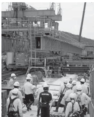
【松浦佐々道路の橋梁見学】
