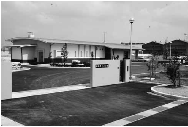
公共下水道終末処理場「松浦水きよら館」
