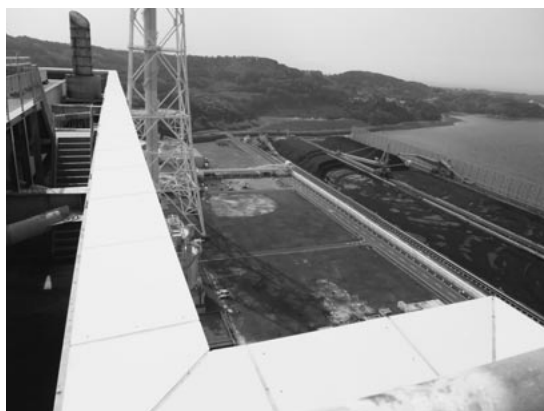
2号機の建設予定地
