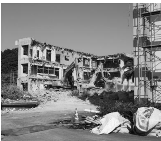
【解体中の旧松浦東高校校舎】
