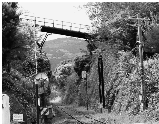
MR線路上の跨線橋 (今福町)
