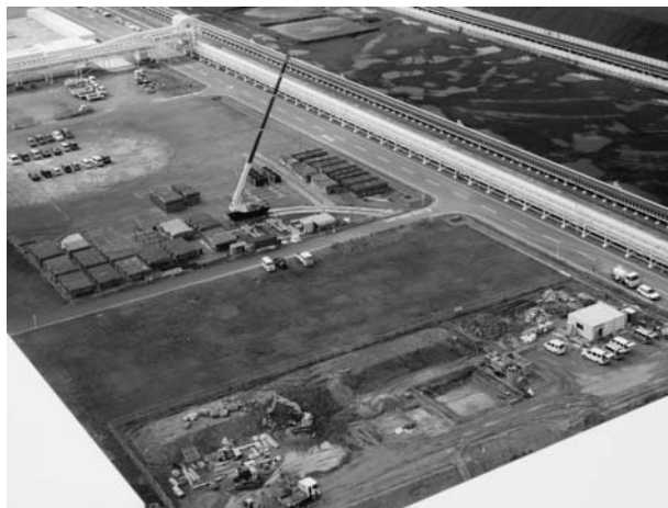
【九電松浦2号機建設地】
