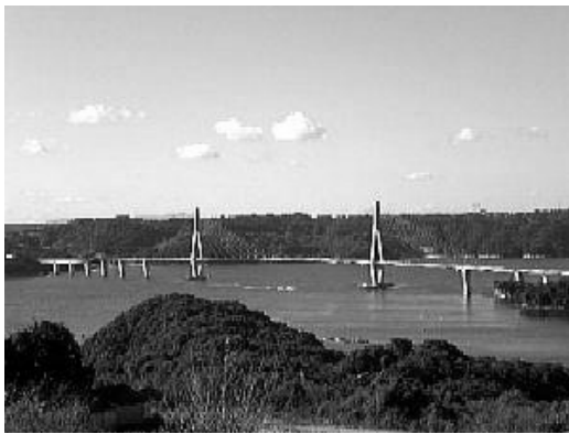
完成間近の鷹島肥前大橋
