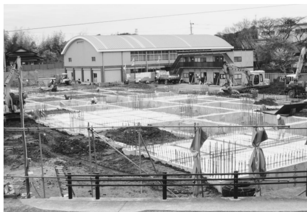
建築中の御厨小学校
