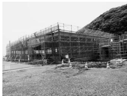
建設中の(有)まさるフーズ水産加工場
