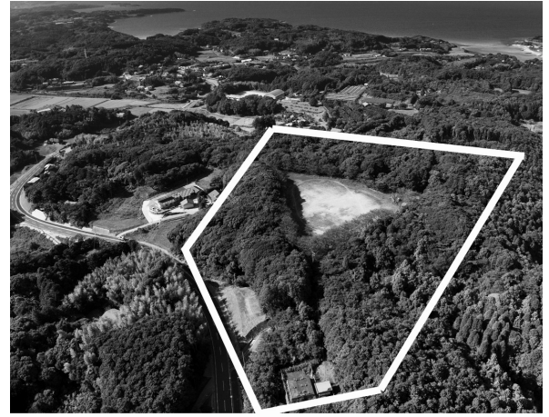
造成中の西部工業団地（御厨町狩原免）
