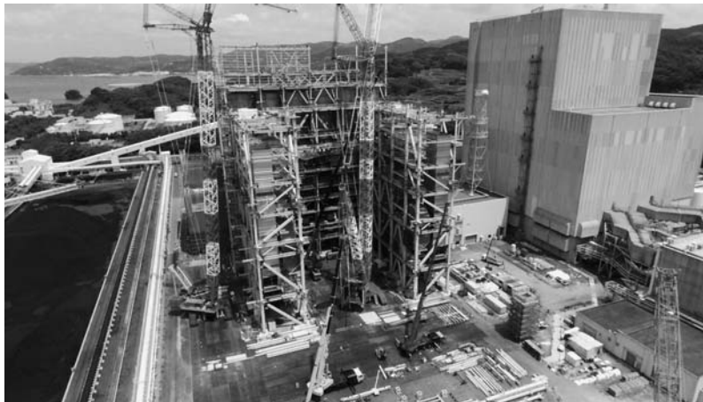
【九電 2号機建設現場】
