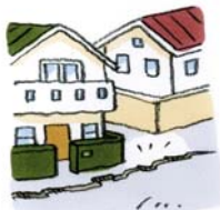
●地面にひび割れや段差ができる
