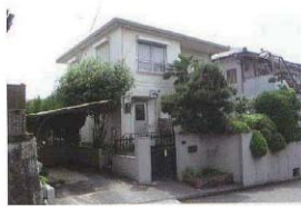
まだ使用できる空き家
