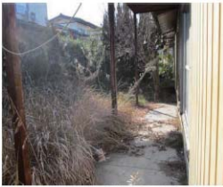
雑草が繁茂した空き家
