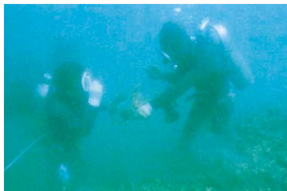
▲床浪港水中作業風景（昭和58年）
