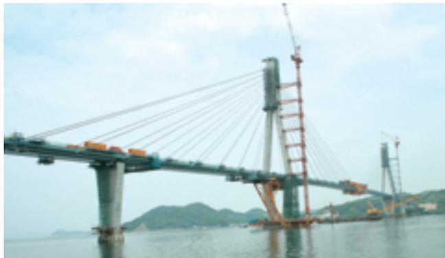
基のクレーンを使って約3時間かけてつり上げ、片側の溶接を行いました。1週間ほどかけて調整を行い、接続工事が完了し、来年3月末に開通予定です。
