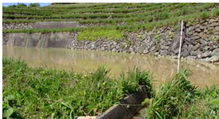
水を無駄にしないよう整備された排水施設
