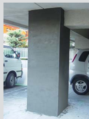
③仕上げを行い完了
