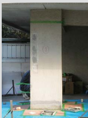
①柱の表面を削る
