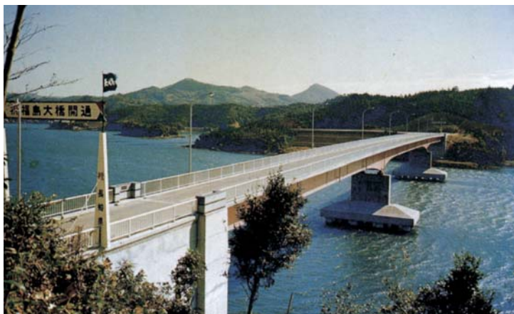
▶完成直後の福島大橋
