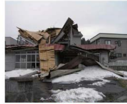
積雪により屋根が落下した空き家
