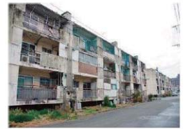
共同住宅の空き家
