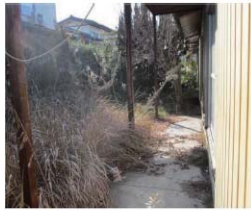
雑草が繁茂した空き家
