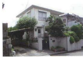
まだ使用できる空き家
