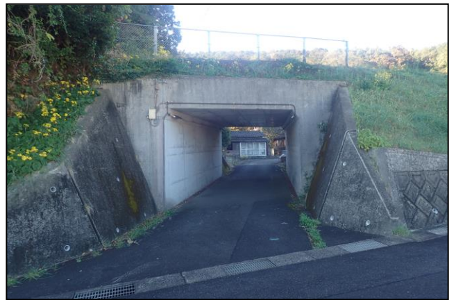
蛭子崎トンネル
