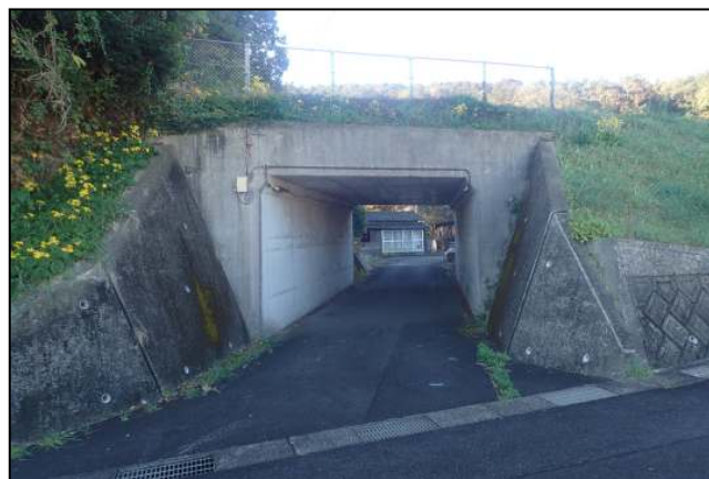
蛭子崎トンネル
