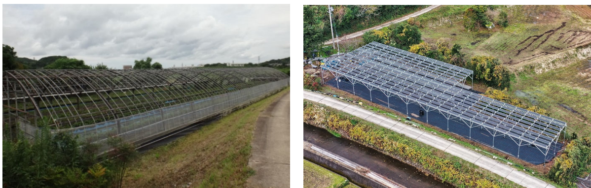
図 1 営農型太陽光実証事業地の様子（右：施工前、左：施工後）
