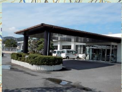
45 川棚町いきがいセンター
