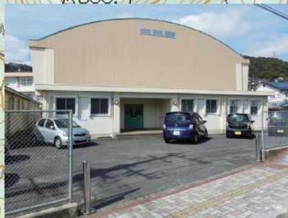
40 川棚町立川棚小学校
