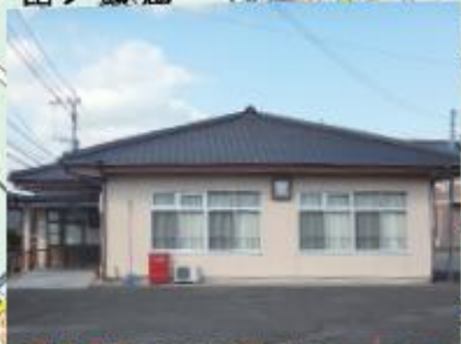
⑦ 折敷瀬集落センター
