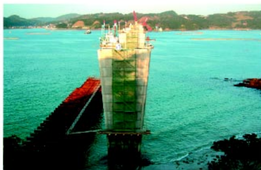
鷹島肥前大橋（仮称）架橋の橋脚
