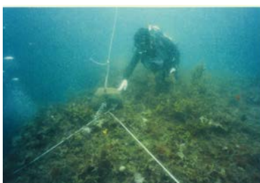
▲床浪港改修工事に伴う調査
