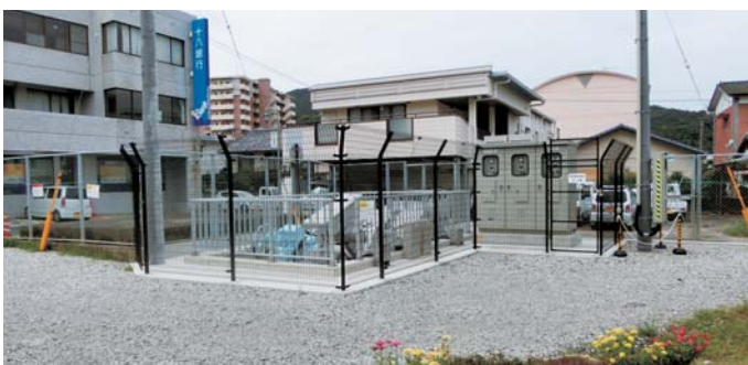
▲中町雨水ポンプ場 稼働開始：平成 30 年 6 月
