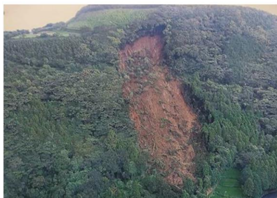
図 6 市道不老山公園線の被災の様子
