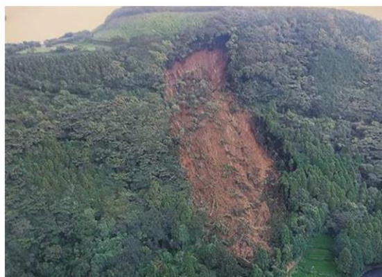
図 6 市道不老山公園線の被災の様子
