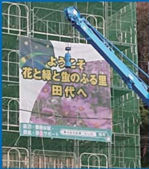
西九州自動車道の建設現場には田代地区の広告を掲示している。
