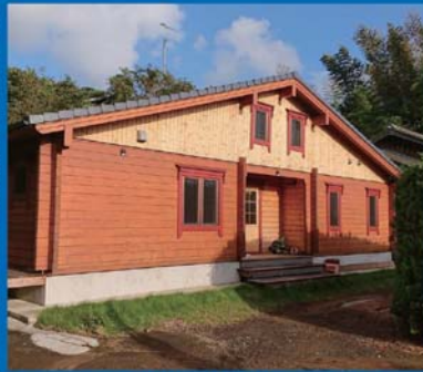
「移住者の選択肢として提示できれば」と、自宅のログハウスを自ら建設中。
