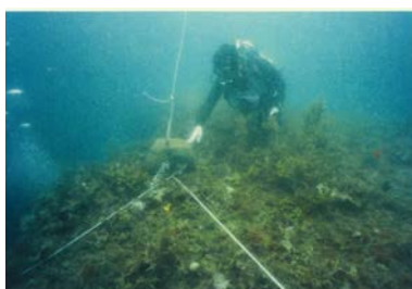
▲床浪港改修工事に伴う調査
