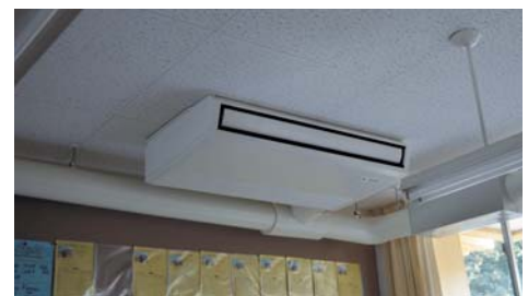
▲小中学校空調設備設置事業
